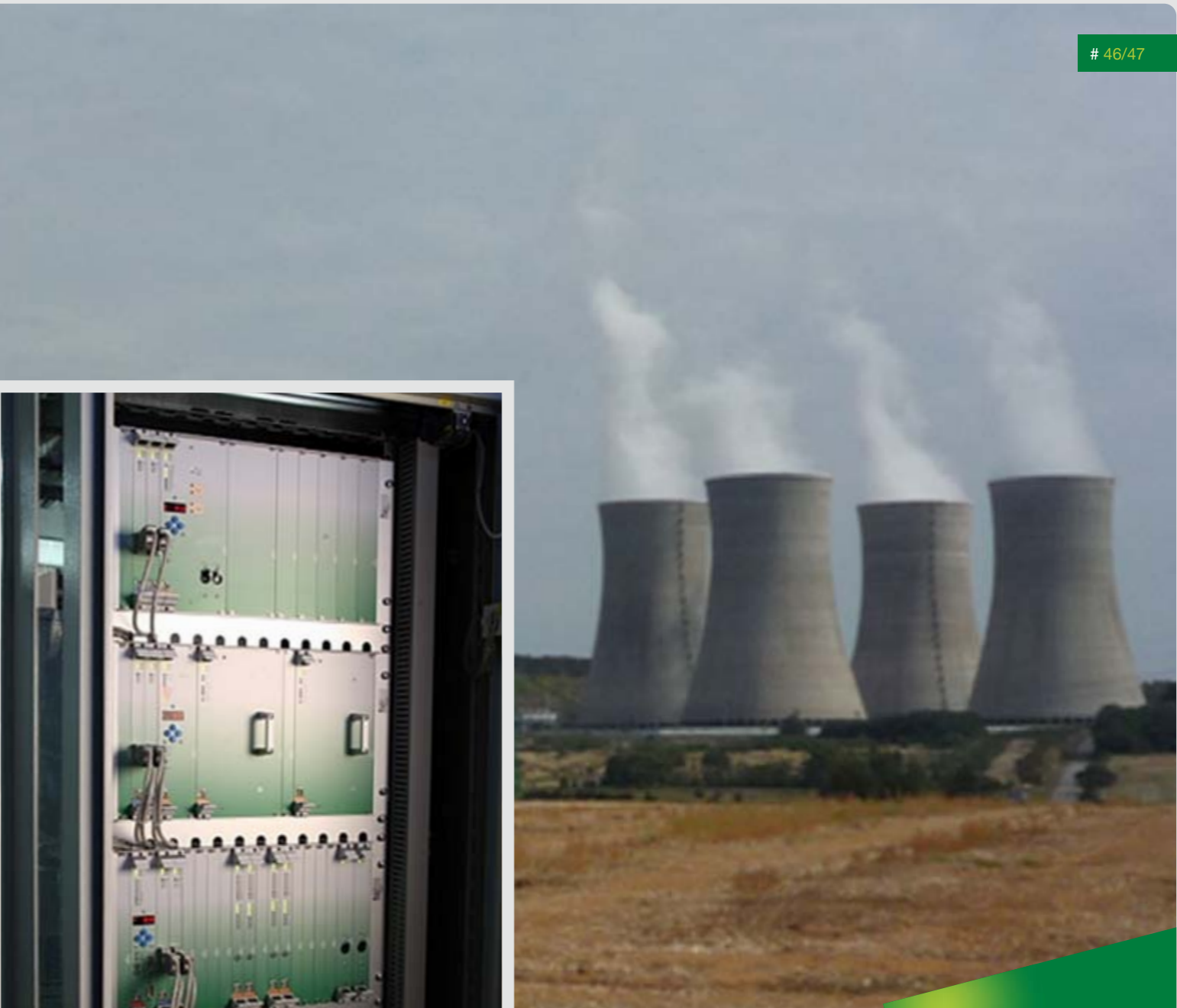
2011 – Jaderná elektrárna Mochovce - Slovensko / RRCS pro reaktory VVER 440 – skříň stendu KS15 pro ovládání pohybu tyčí a vyhodnocení jejich polohy
