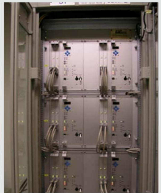
2009 – Jaderná elektrárna Dukovany - Obnova SKŘ M1, M2 stavba T544 PCS – Procesní počítačový systém / RRCS systém pro řízení regulačních kazet reaktoru
