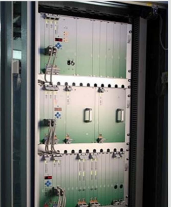
2011 – Jaderná elektrárna Mochovce - Slovensko / RRCS pro reaktory VVER 440 – skříň stendu KS15 pro ovládání pohybu tyčí a vyhodnocení jejich polohy
